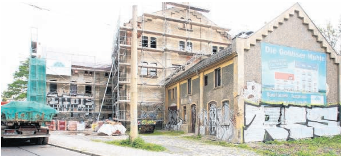
Auf dem Areal der früheren Wassermühle an der Platnerstraße laufen die Sanierungsarbeiten auf Hochtouren. Foto: André Kempner
