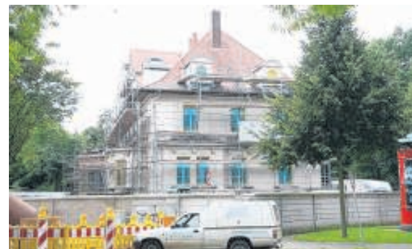
Noch diesen Monat fallen die Gerüste an der ehemaligen Fabrikantenvilla am Poetenweg. Foto: André Kempner
